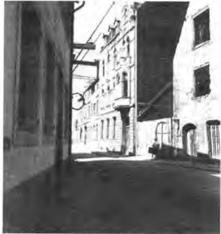
An der Krahenstraße sind die Schäden des 2. Weltkrieges (1939 – 1945) klar ersichtlich
