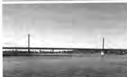
Die Leverkusen – Kölner Autobahnbrücke in südlicher Blickrichtung; nach fast 50 Jahren muß die Brücke komplett restauriert werden
