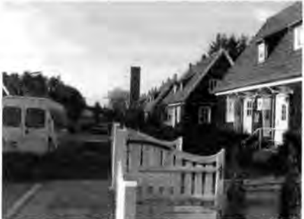
Der Lippeweg in Köln-Höhenhaus mit der (teilweise unter Denkmalschutz stehenden) „Schwedenhaus“-Bebauung, Holzhäuser mit Teerabdichtung
