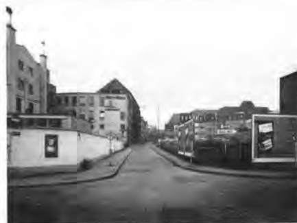
Blick in die Neven-DuMont-Straße, die zur Zeit der Aufnahme (Ende der 1950er Jahre) noch Langgasse hieß (links das alte Verlags- und Druckereigebäude des Kölner Stadtanzeigers)
