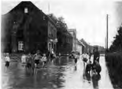
Die Hauptstraße in Widdersdorf, überschwemmt nach einem kräftigen Regen; um 1930
