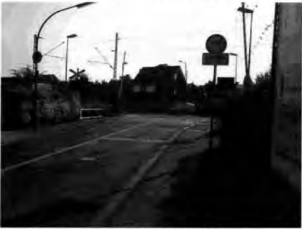
Der Bahnübergang der Deutschen Bahn bereitet seit vielen Jahren Probleme
