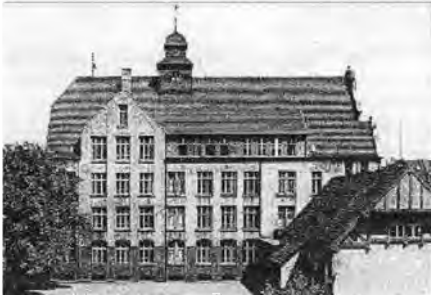
Die ehemalige evangelische Volksschule (Foto um 1925) wurde zum 31.7.2012 aufgelöst
