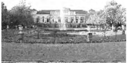
Das Festhaus in der Flora mit vorgelagertem Springbrunnen, gegenüber des Haupteingangs an der Straße „Alter Stammheimer Weg“
