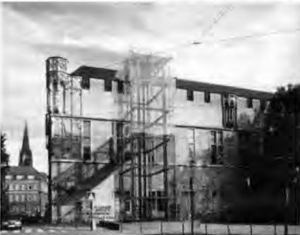
Der Gürzenich, die „Gute Stube“ von Köln (mit gläsernem Lastenaufzug auf dem Günter-Wand-Platz)
