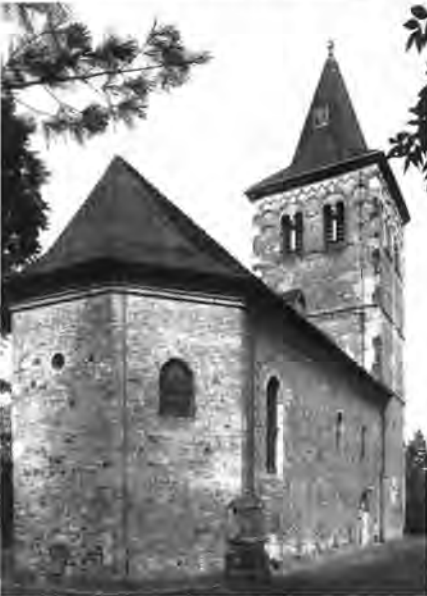
Die ehemalige Pfarrkirche St. Martin in Porz- Oberzündorf
